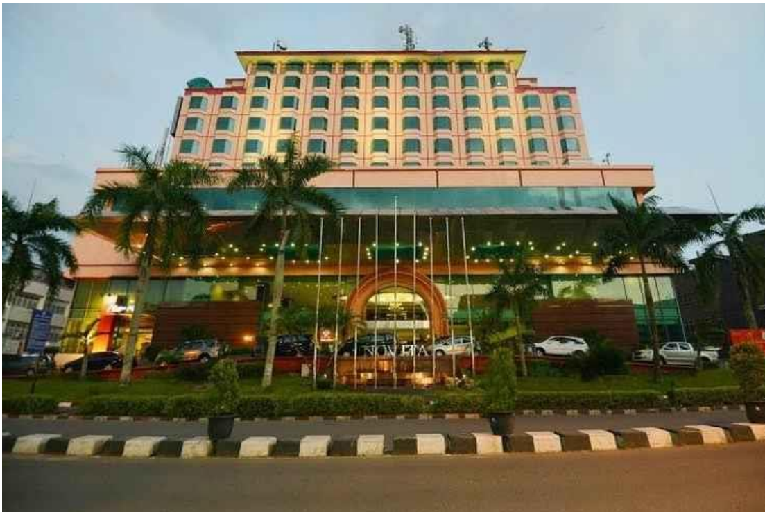
Novita hotel (dh. Novotel) sebelum mengalami kebakaran
