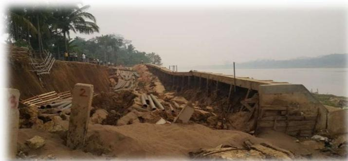
Pada pembangunan tersebut sebelumnya diuji dengan sondir dengan menentukan kedalaman tanah keras. Ternyata pada tahun 2015 terjadilah longsor yang mana longsor tersebut terjadi
