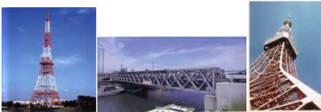
Gambar 1.1. Struktur Rangka Batang ( Truss )
