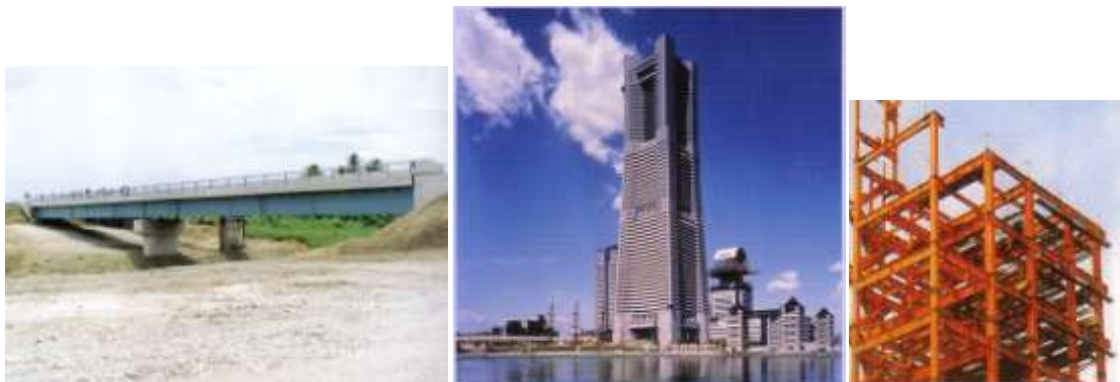
Gambar 1.2. Struktur Rangka Kaku ( Frame )
