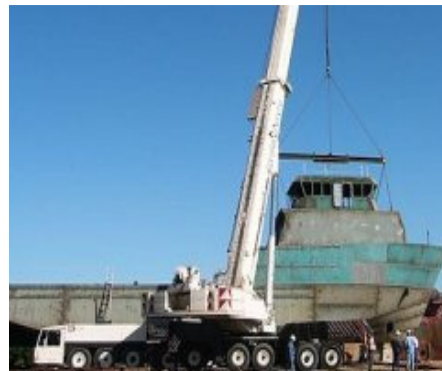
f. Mobile Crane
