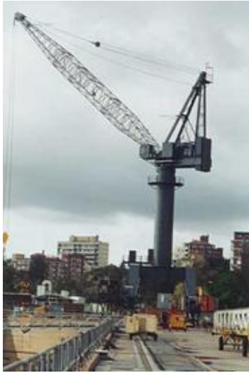
a. Crane Putar , banyak digunakan di pelabuhan laut
