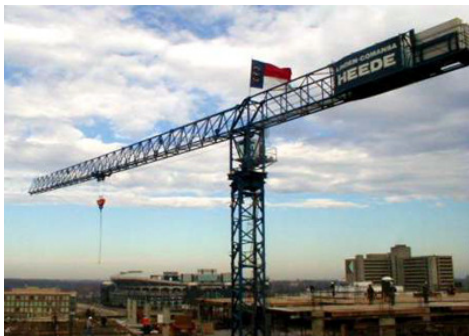
e. Crane Menara
