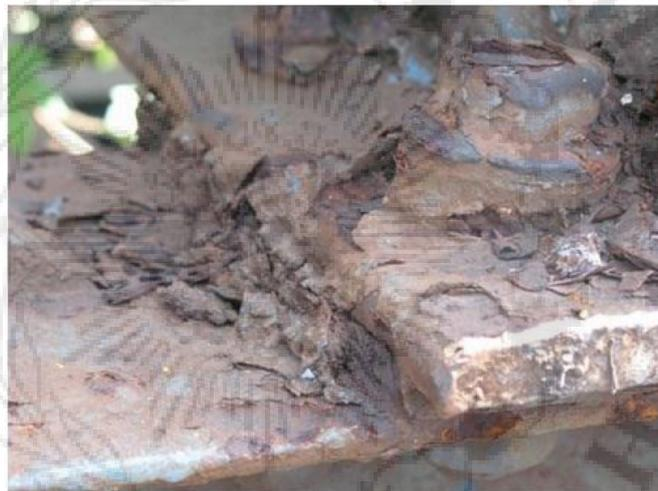
**Gambar 2.5.2:** Korosi Adanya Tumpukan Zat pengotor.
