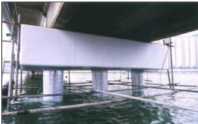
**Gambar 26 – Contoh setelah diberi fibre composite**
