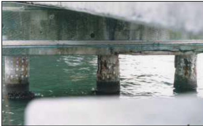
**Gambar 25 – Contoh Sebelum Diberi Fibre Composite**
