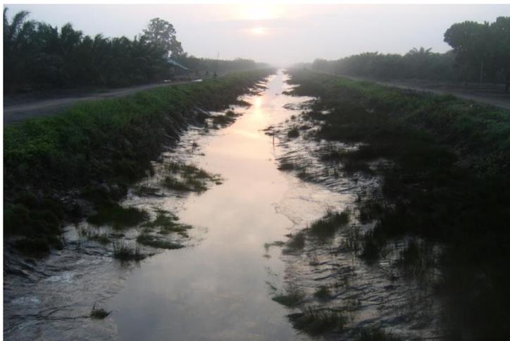
Gambar 15. Pada musim kemarau hampir semua saluran primer/sekunder di lahan rawa mengalami penurunan muka air sangat signifikan sehingga alur lalu lintas air tidak bisa digunakan. Penanganan ini memerlukan pendekatan pengelolaan menurut satuan hidrologi secara terpadu dan komprehensif
