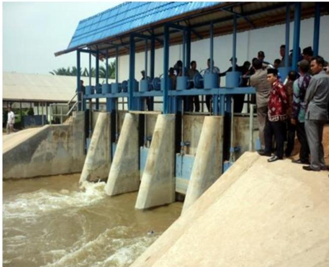
Gambar 23. Dalam pengelolaan tata air makro pada lahan rawa lebak dikenal sistem polder. Dalam sistem polder diperlukan bangunan air, saluran besar, pompa *inlet*, pompa *outlet*, dan tanggul keliling yang kokoh. Bangunan air yang terdiri dari pompa digunakan dalam sistem polder Alabio pada lahan rawa lebak Kabupaten Hulu Sungai Utara, Kalimantan Selatan
