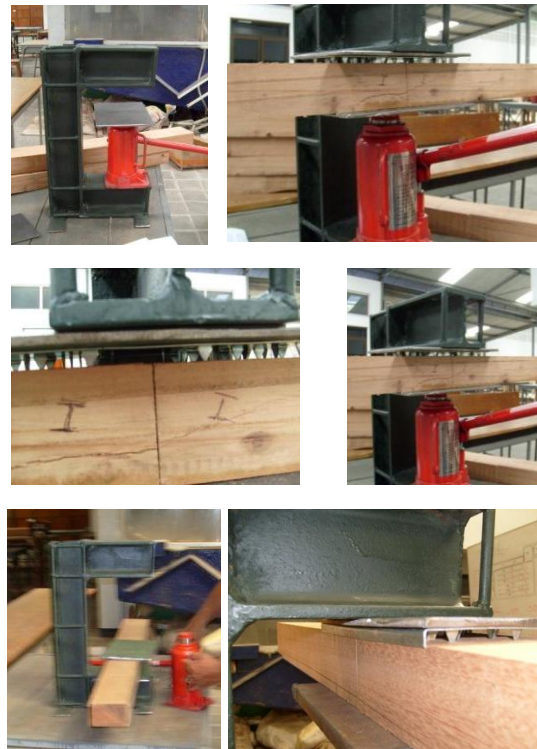
Gambar 11 Susunan urutan Pemasangan Alat Sambung Konstruksi Kayu
