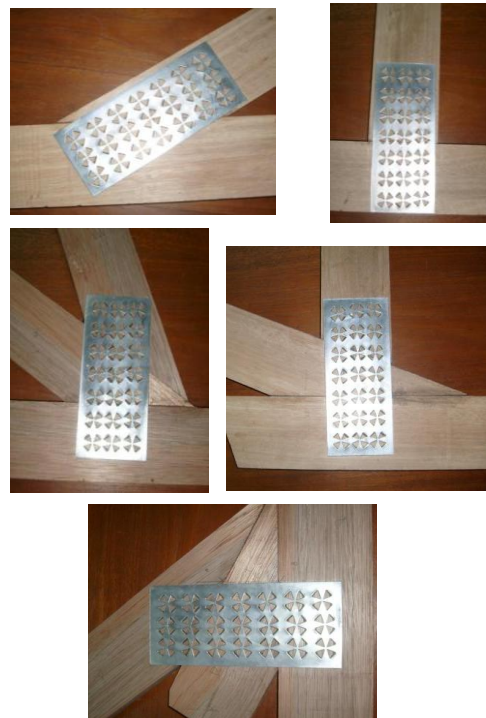
Gambar 12 Cara pemasangan alat sambung pada konstruksi sambungan
