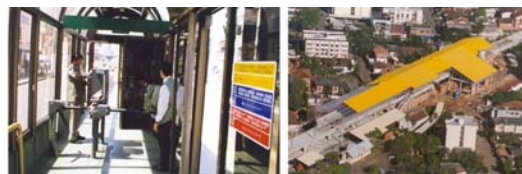
Stasiun BRT di Quito, Ekuador: US$ 35.000
