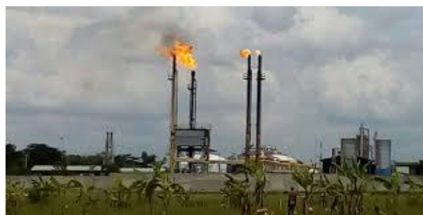
Gambar 5. Teknologi Sistem Pembakaran (Flaring System)
