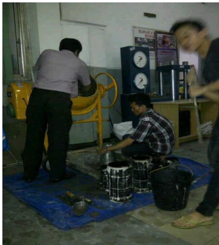
Foto. Proses pembuatan adukan beton
