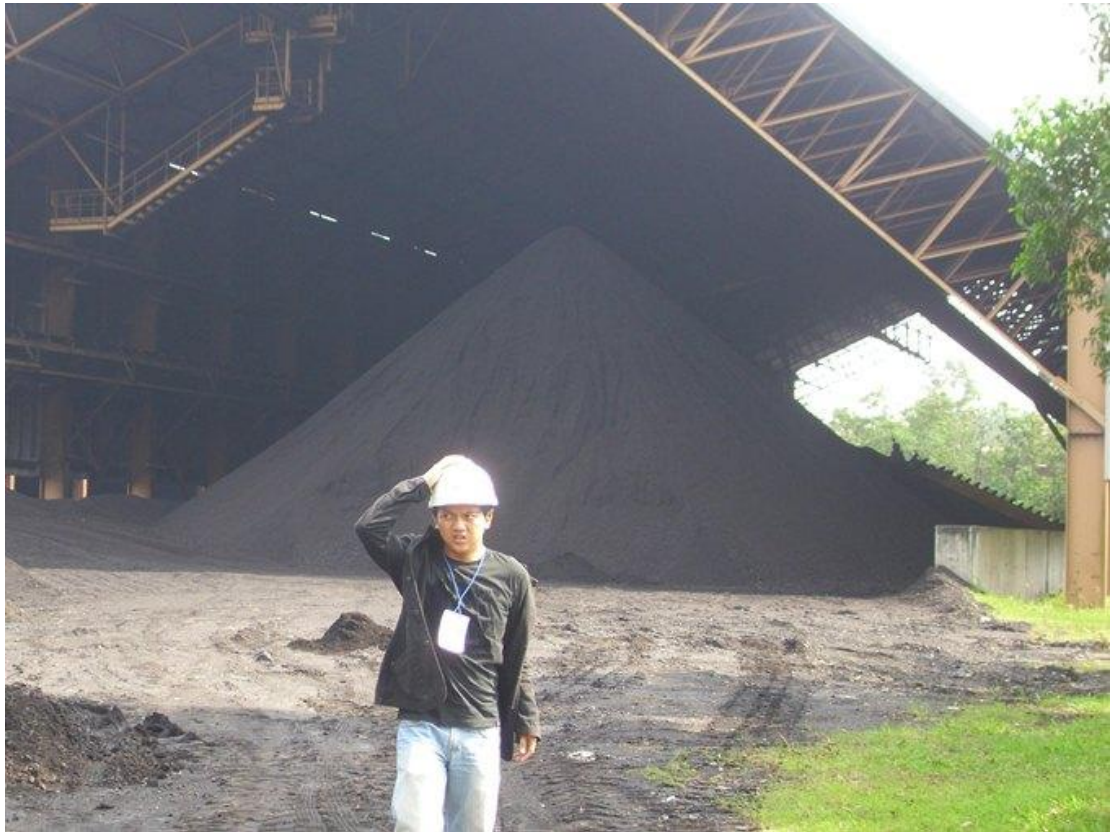
Foto. Tempat Penampungan Bottom Ash PLTU Bukit Asam
