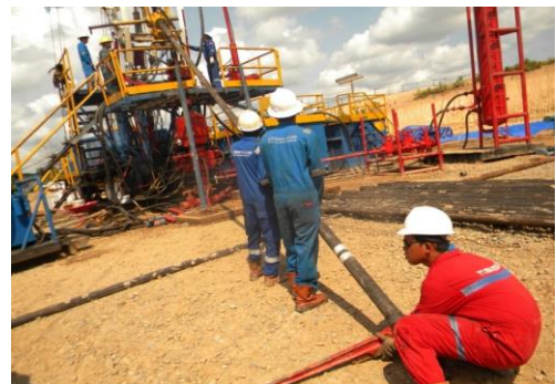
Gambar Pekerjaan perbaikan sumur pada PT Bina Mitra Artha
