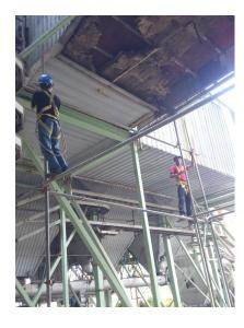
Pada gambar diatas menunjukkan proses pemasanagn Scaffolding (Perancah) untuk memperbaiki ducting ID Fan yang telah rusak.
